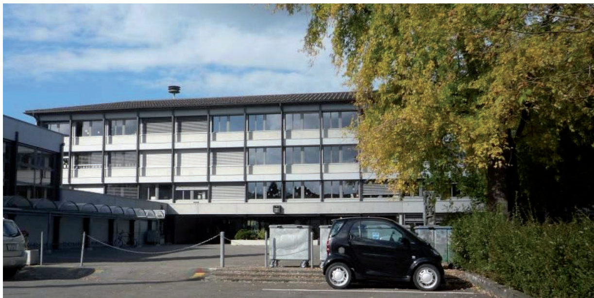
Schul- und Zivilschutzanlage Amlehn in Kriens: mit Energiespar-Contracting saniert. Die geplante Einsparung wurde um 22% übertroffen. Bild: Siemens Schweiz AG / Gemeinde Kriens
