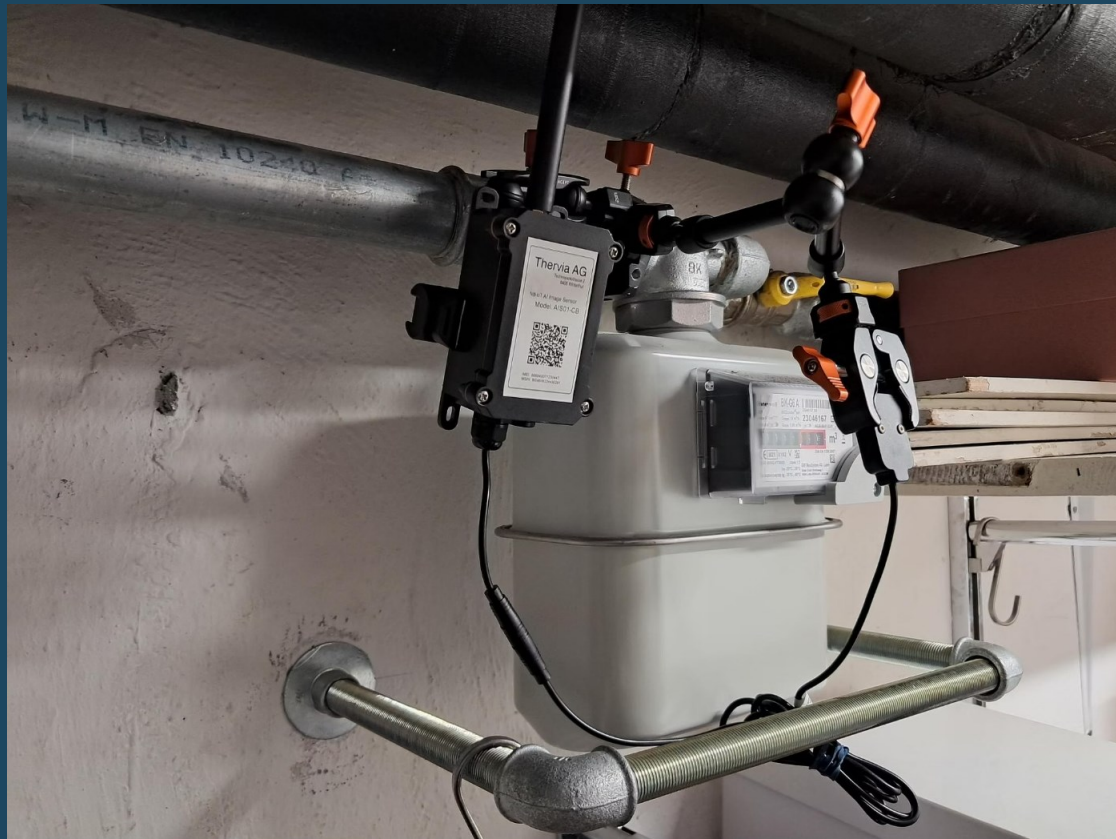
IoT-Kamera montiert vor dem Gaszähler
