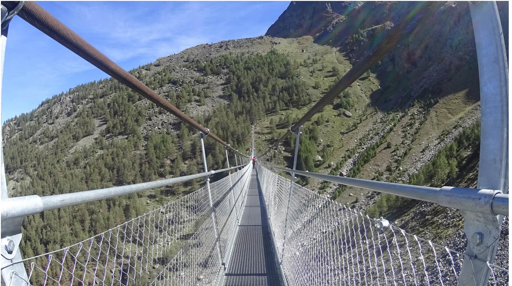
Pont de Randa (VS) © www.monter-en-haut.ch
