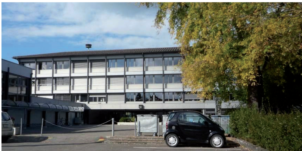
Établissement scolaire et abri de protection civile Amlehn à Kriens : rénovés avec un contrat de performance énergétique. L'économie prévue a été dépassée de 22%. Photo : Siemens Suisse SA / Commune de Kriens
